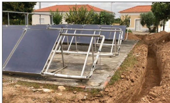
Abertura de vala para passagem da rede de água no Lar de Casa Branca
