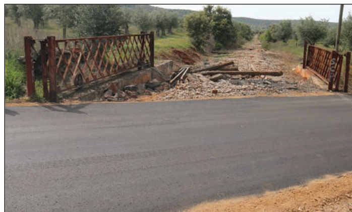
Câmara coloca alcatrão nas antigas passagens de nível
