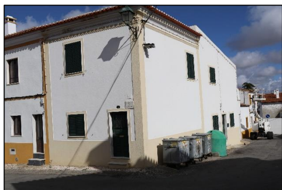
Figura 11 – Exemplo de edifício de nível 4
