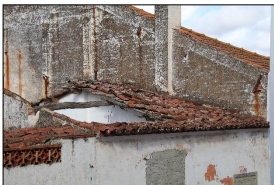
Figura 7 – Exemplos de edifícios com problemas a nível da sua cobertura
