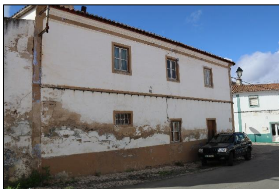
Figura 146 – Exemplo de edifício de nível 1
