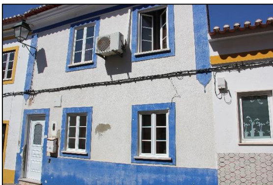
Figura 13 – Exemplo de edifício de nível 3
