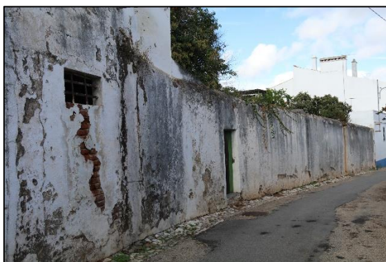
Figura 6 – Exemplos de edifícios com problemas ao nível das paredes exteriores
