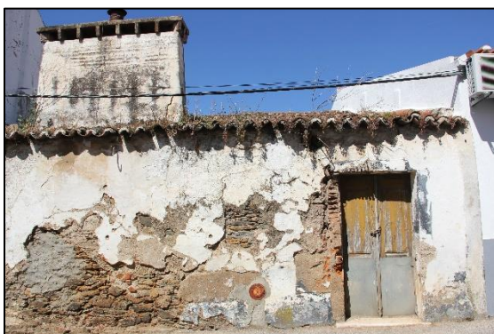
Figura 135 – Exemplo de edifício de nível 1
