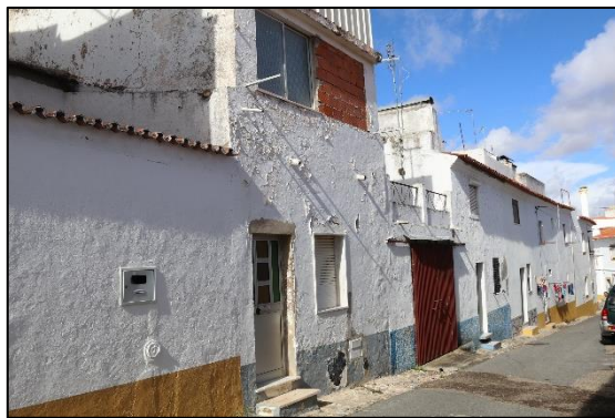
Figura 14 – Exemplo de edifício de nível 2
