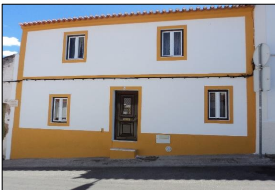
Figura 121 – Exemplo de edifício de nível 5
