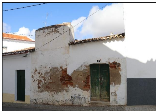
Figura 6 – Exemplos de edifícios com problemas ao nível das paredes exteriores
