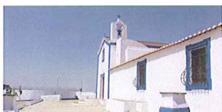
Figura 4 – conjunto edificado (vista S/N)
