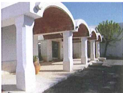
Figura 22 – entrada principal marcada por 4 abobadilhas de canhão
