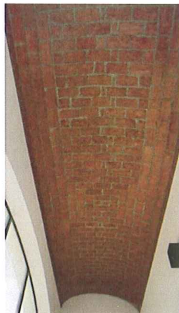
Figura 24 – abobadilhas de canhão no acesso às áreas
