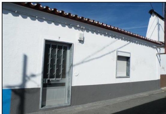
Exemplo de edifício de nível 4
