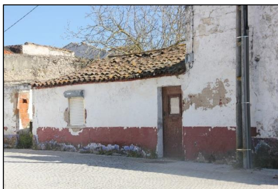
Exemplo de edifício de nível 1
