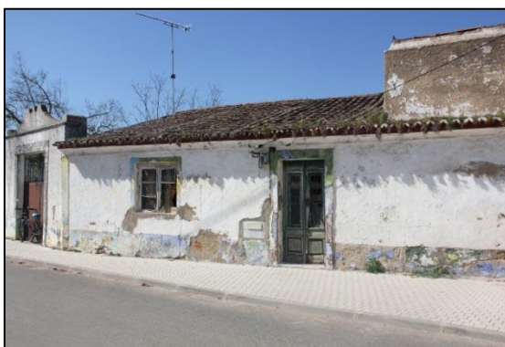
Exemplo de edifício de nível 1
