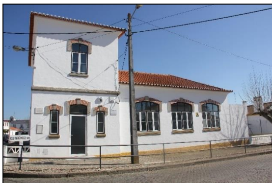
Edifício Reabilitado – CAO / Vista Central
