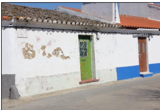
Exemplo de edifício de nível 2
