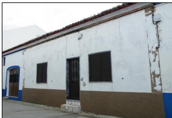
Exemplo de edifício de nível 3
