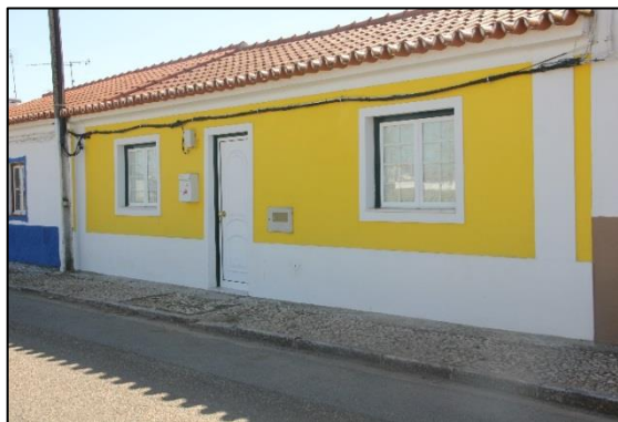
Exemplo de edifício de nível 5
